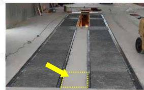
NECESSITA' DI TAMPONAMENTI CENTRALI
